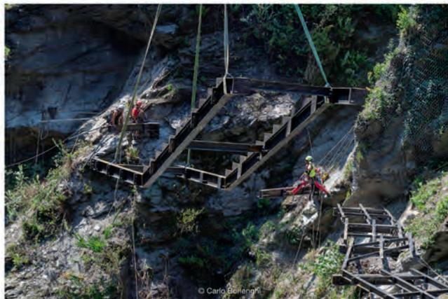
Operazione di fissaggio delle strutture delle nuove passerelle alle pareti rocciose dell'Orrido con squadre di montatori specializzati per lavori in acrobatico
